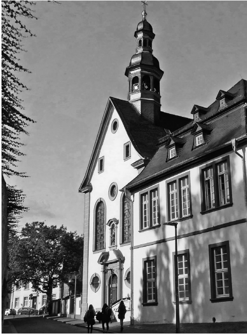
Abb. 2: Welschnonnenkirche mit Schulgebäuden in der Flanderstraße.
