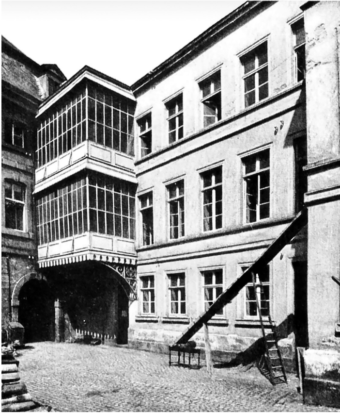
Abb. 11: Der gegen Ende des 19. Jh. errichtete Anbau eines Archivgebäudes mit verglaster Pergola im Innenhof (aus Les Cahiers Luxembourgeois 1937).
